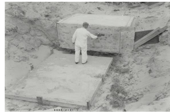
Déchets accumulés (enterrés et stockés)
